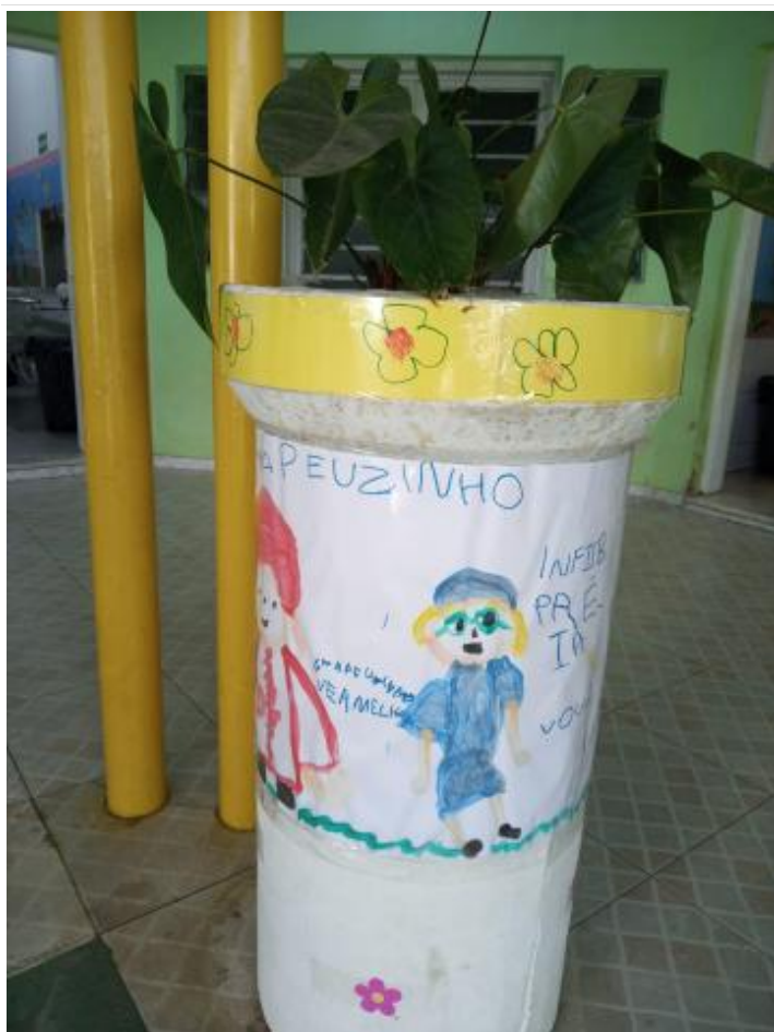
REESTRUTURAÇÃO DA ÁREA EXTERNA - MANILHAS
