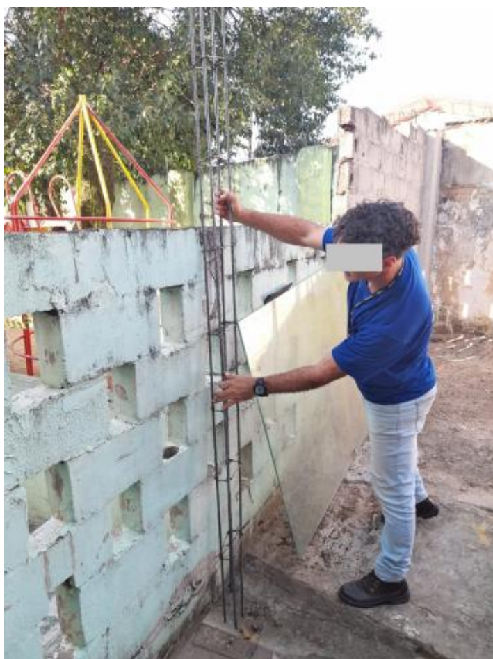
REPARO DO MURO
